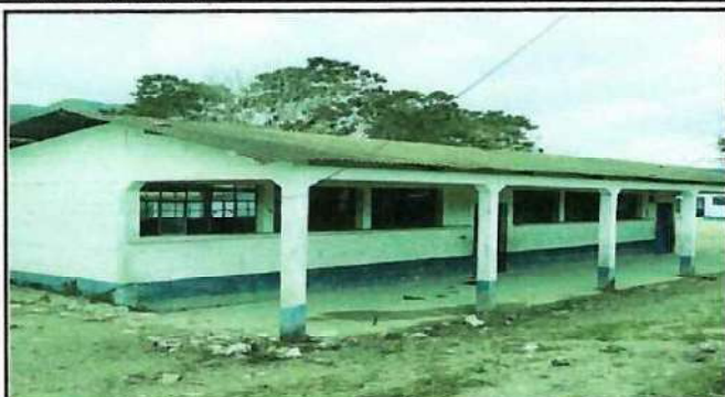
Foto 1: Lado Este frente del edificio anterior
