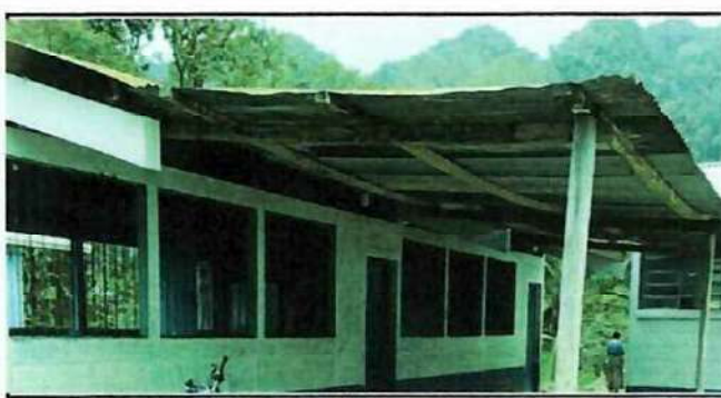
Foto 6: Lado Norte y frente del edificio cuando no se ha cambiado el techo
